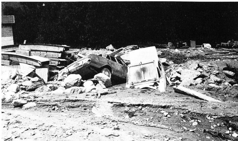
Bild 2. Die Murgangabflüsse der Vallatscha im Müstertal/Kt. Graubünden in der Periode 30. April bis 22. Juni 1977 verursachten nicht nur im Bereich des Wildbaches grosse Schäden, sondern veränderten auch den Vorfluter II Rom erheblich durch massive Geschiebeablagerungen, Flusslaufverlegungen und damit verbundene Uferabbrüche. Folgeschäden waren bis ins italienische Grenzgebiet spürbar.
