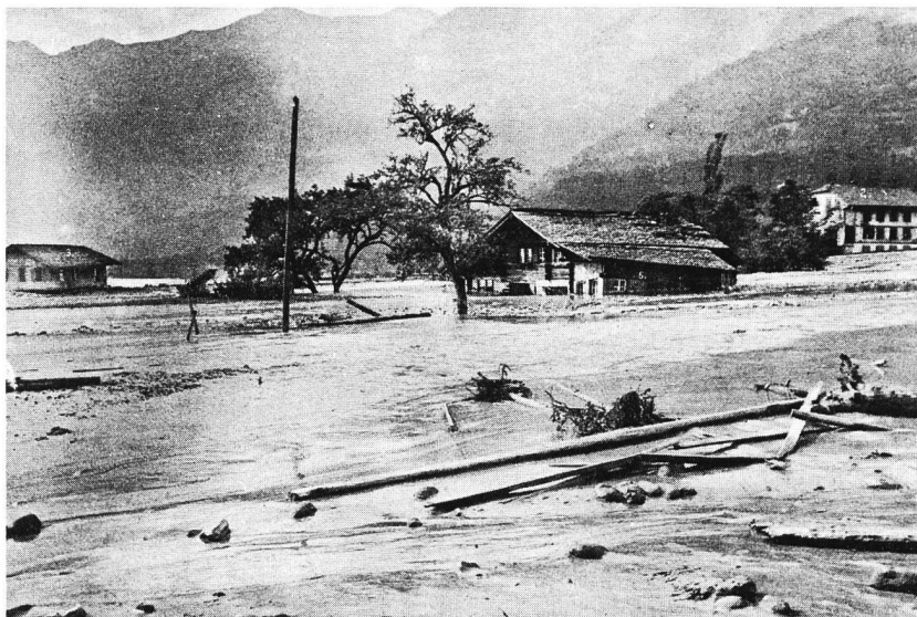
Bild 2, links. Schwere Schäden richtete die Überschwemmung des Lambbaches im Jahre 1896 an, als der unverbaute Bach innert kürzester Zeit 300 000 m 3 Geröll und Erde mit sich riss. Häuser versanken meterhoch im Schlamm und wurden gar aus ihren Fundamenten gerissen, die Strasse und die Geleise der Brünigbahn wurden unterbrochen.
