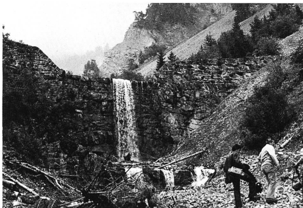
Bild 1. Die alten Lammbachsperrren sind ein wahres Meisterwerk des Tiefbaus, mit einfachsten Mitteln unter schwierigsten Bedingungen gebaut. Sie müssen laufend überwacht werden und brauchen ständigen Unterhalt, wenn sie ihre wichtige Aufgabe zuverlässig erfüllen sollen.
