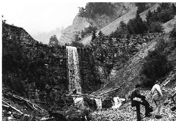
Bild 1. Die alten Lammbachsperrren sind ein wahres Meisterwerk des Tiefbaus, mit einfachsten Mitteln unter schwierigsten Bedingungen gebaut. Sie müssen laufend überwacht werden und brauchen ständigen Unterhalt, wenn sie ihre wichtige Aufgabe zuverlässig erfüllen sollen.
