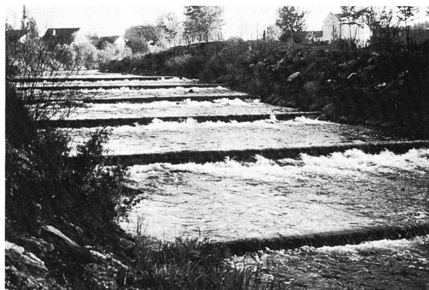
Das baufällige, 2 m hohe Wehr einer kleinen Wasserkraftanlage wurde durch 6 aufeinanderfolgende Doppelrundholzschnellen ersetzt. Der Umbau erfolgte aufgrund von Modellversuchen an der VAW.
