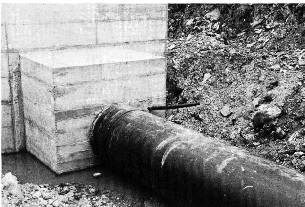
Bild 5. Der Fixpunkt am Turbinenhaus.
