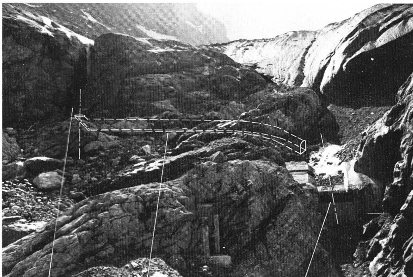
Bild 3. Am rechten Bildrand das Einlaufbauwerk der Wasserfassung Bifertenbach II. Darüber die Gletscherzunge des Bifertenfirns. Seit dem Zeitpunkt der Aufnahme dieser Photo (1978) ist der Bifertengletscher weiter vorgestossen und hat das Einlaufbauwerk vollständig überfahren. Durch den Gletschervorstoss haben sich die Abflussverhältnisse im Bifertenbach II verändert. Ein Teil des Wassers wurde durch das vorstossende Eis abgedrängt und floss durch die in der linken oberen Bilddecke erkennbare Felskluft ab. Um dieses Wasser wieder der Nutzung zuzuführen, musste der im Bild eingezeichnete Stollen vorgegraben und das Wasser am unteren Ende der Felskluft gestaut und dem ursprünglichen Gerinne des Bifertenbeckens II zugeleitet werden. Seither fliesst das Wasser wieder zum Einlaufbauwerk (seit 1981 unter dem Gletschereis) und von hier zum Stausee Limmernboden.
