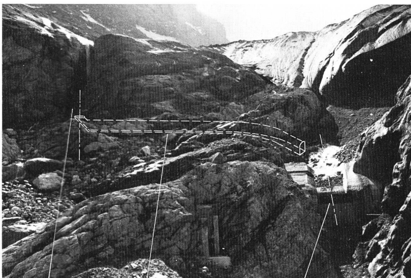
Bild 3. Am rechten Bildrand das Einlaufbauwerk der Wasserfassung Bifertenbach II. Darüber die Gletscherzunge des Bifertenfirns. Seit dem Zeitpunkt der Aufnahme dieser Photo (1978) ist der Bifertengletscher weiter vorgestossen und hat das Einlaufbauwerk vollständig überfahren.
