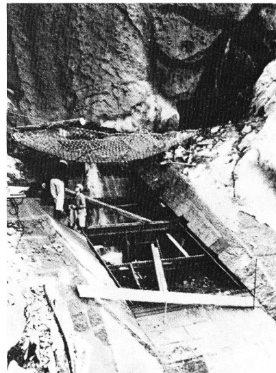
Bild 1, links. Die Wasserfassung des Bifertenbaches I. Unterhalb der Bildmitte ist das Fassungsbauwerk (Einlaufrechen) sichtbar. Vom Gletscher, der oberhalb der Fassung hängt, war zur Zeit der Erstellung der Fassung (Anfang der 60er Jahre) noch nichts zu sehen. Fast täglich brechen aus der Gletscherstirne mehr oder weniger grosse Eisstürze los, die eine Verstärkung des Einlaufrechens erforderten. Rechts und unterhalb der Fassung ist herabstürzendes Eis erkennbar.
