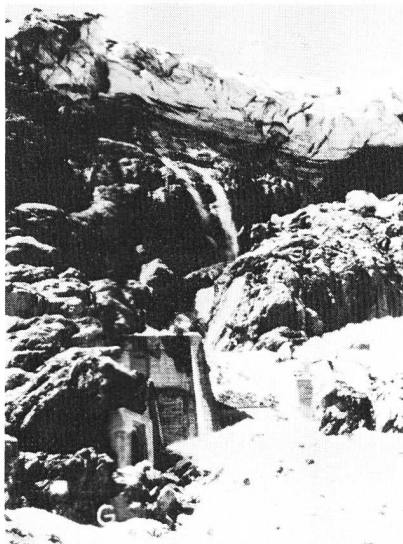
Bild 1, links. Die Wasserfassung des Bifertenbaches I. Unterhalb der Bildmitte ist das Fassungsbauwerk (Einlaufrechen) sichtbar. Vom Gletscher, der oberhalb der Fassung hängt, war zur Zeit der Erstellung der Fassung (Anfang der 60er Jahre) noch nichts zu sehen. Fast täglich brechen aus der Gletscherstirne mehr oder weniger grosse Eisstürze los, die eine Verstärkung des Einlaufrechens erforderten. Rechts und unterhalb der Fassung ist herabstürzendes Eis erkennbar.
