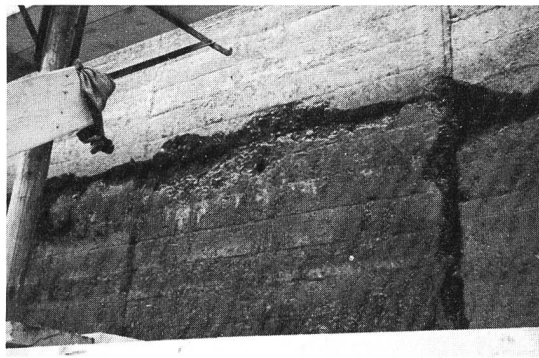
Bilder 3, 4 und 5. Staumauer Schöni. Einzelheiten der Betonschäden auf der Wasserseite.
