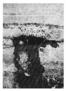
Bilder 3, 4 und 5. Staumauer Schöni. Einzelheiten der Betonschäden auf der Wasserseite
