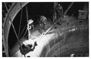
Bild 1. Blick von Osten in den Einlauf der Turbine 3 des Kraftwerkes Ryburg-Schwörstadt. Von oben wird der etwa zentrisch aufgehängte Pumpenschlauch in die einzelnen Füllöffnungen, in denen die Leitschaufellager eingesetzt werden, eingeführt und der Beton in den Hohlraum hinter den Laufradmantel eingefüllt.
