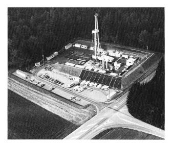
Bild 1. Das Bohrgelande Böttstein. In der Bildmitte steht der 44 m hohe Bohrturm, rechts davon schliesst die Maschinenplattform an, auf der die elektrischen Antriebsorgane untergebracht sind. Links am Bildrand – in einem umgebauten Schiffscontainer – die ständige Informationsausstellung der Nagra, die täglich von 13 bis 17 Uhr besucht werden kann.
