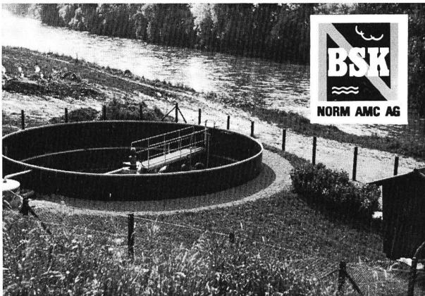
Nachklärbecken können problematisch sein. Besonders bei kleinen Anlagen treten immer wieder Schwierigkeiten mit aufschwimmendem Schlamm auf, welcher die Reinigungsleistung abmildert. Zudem erfordern separate Nachklärbecken einen zusätzlichen Investitions- und Wartungsaufwand.
