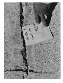
partie centrale du parement amont, on observe une ouverture des joints verticaux depuis le couronnement jusqu'à la même cote environ (figure 1).
