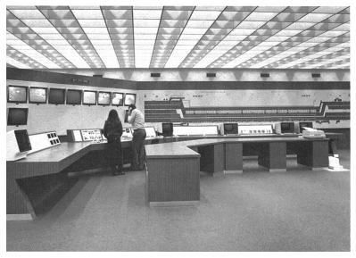
Blick in die Kommandozentrale Göschenen des Gotthard-Strassentunnels, Seite Verkehrsüberwachung durch die Polizei. Rechts schliesst die Betriebs- überwachung für Belüftung, Beleuchtung, Energieversorgung usw. an. In Airolo ist eine analog ausgerüstete Kommandozentrale installiert. Das Kommando wechselt im Turnus von zwei Wochen zwischen den beiden Kommandozentralen Göschenen und Airolo.
