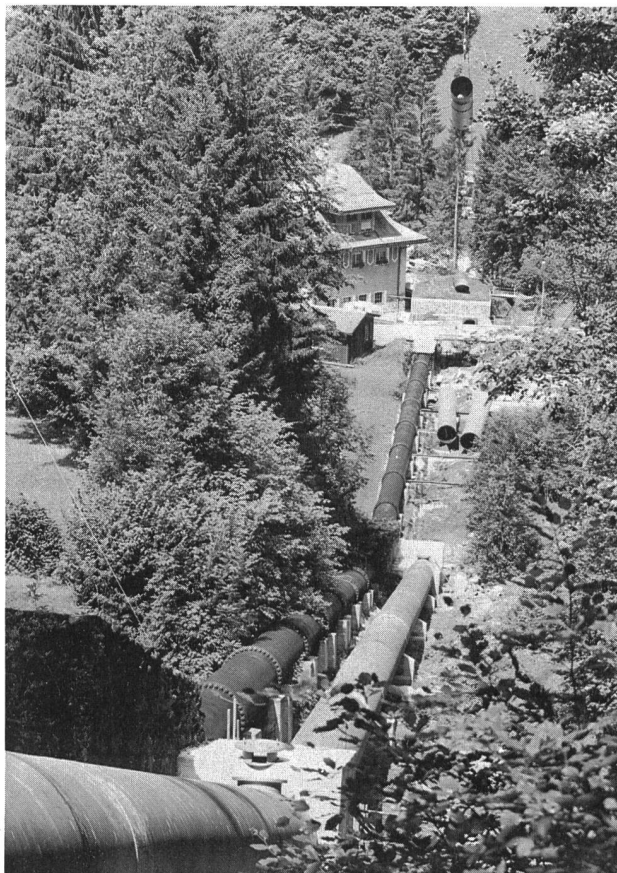
Neubau der Druckleitung des Jungfraubahn-eigenen Kraftwerkes Burglauenen mit einer Länge von 430 m und einem Rohrdurchmesser von 1,40 m. Die neue Leitung wurde in 3 m Abstand östlich zur gleich grossen alten verlegt (welche inskünftig als Überlauf- und Abschwemmleitung dient), weist jedoch dank besseren Qualitätskennwerten der Rohre bis auf 16 m vergrösserte Abstände der Stützsockel auf. Da eine neue Verteilleitung für die fünf Turbinen extrem teuer wäre (Rohrverzweigungen kosten pro Tonne Gewicht etwa achtmal mehr als gerade Rohre), wird die bestehende Verteilleitung beibehalten, jedoch mit einem armierten Betonmantel verstärkt. (Foto: JB)
