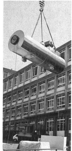
Die komplett vormontierte TVA am Kranhaken, auf dem Weg zum Aufstellungsort.
