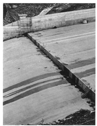
Bild 4. Hochwasserentlastung Pedra do Cavalo. Foto der Schussrinne mit Belüftungsdispositiv gemäss Bild 2, Bauzustand Mai 1982.
