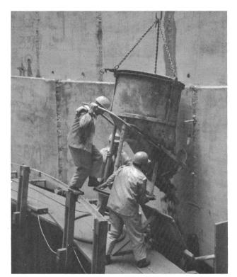
Bild 4. Betonieren der Schachtauskleidung in 3.00 m hohen Ringen für den
