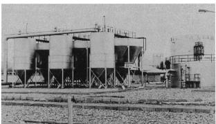
Bild 5. Absetzanlage mit Vorflocker und Schrägklärer (Isfahan)
