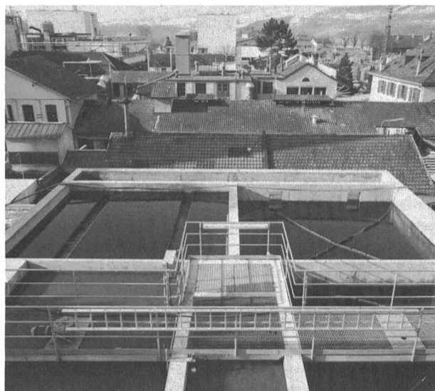
Bild 3. Absetzanlage mit Vorflocker und Schräglklärer (Firmenich AG).
