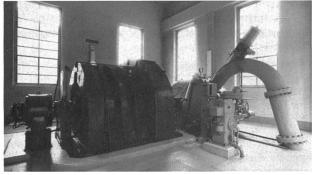
Bild 10. Der mit der Tubine gekuppelte Dreiphasengenerator in geschlossener Bauweise.
