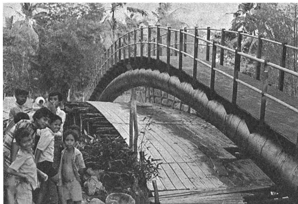
Bild 4. Flussüberquerung der Transportleitung als Rohrbogenbrücke mit aufgesetztem Fussgängersteg ausgebildet.
