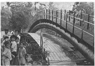
Bild 4. Flussüberquerung der Transportleitung als Rohrbogenbrücke mit aufgesetztem Fussgängersteg ausgebildet.
