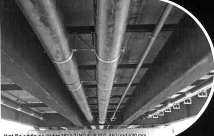
Hart-Polyaethylen-Rohre ND 3,2/ND 4, Ø 200, 450 und 630 mm
