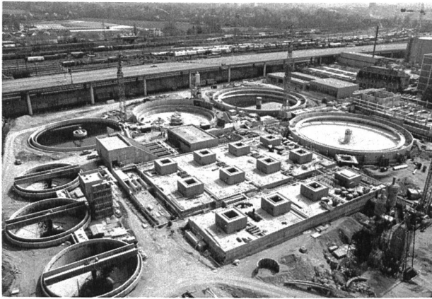
Bild 4. Abwasserreinigungsanlage im Bau.
