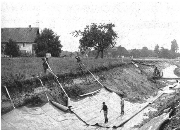
Bild 3. Aufziehen der in der Kanalachse verlegten Kunststoffbahn mit Hilfe der eingerollten Bänder. Die Bänder werden anschliessend an vorher eingeschlagenen Pfählen befestigt.
