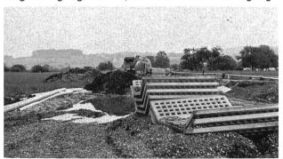
Bild 1. Bereitgestelltes Baumaterial. Links die doppelt gegen die Mitte eingerollten Bahnen KDB aus Sarnafil-FP (LDPE) extrudiert in 2 mm Stärke. Gleichzeitig wurden Bänder eingerollt, die das Aufziehen auf beide Böschungen erleichtern. Rechts die Kanalelemente aus Beton, die direkt auf das mit dem Bagger eingebrachte Beschwerungsmaterial verlegt werden.
