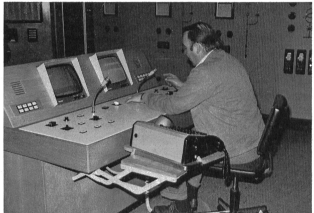
Bild 4. Auf zwei Monitoren im Fernsteuerpult des Kraftwerks können die Bilder der verschiedenen Fernsehkameras wiedergegeben werden. Von hier aus wird die ganze Übersetzaktion kommandiert und ferngesteuert.
