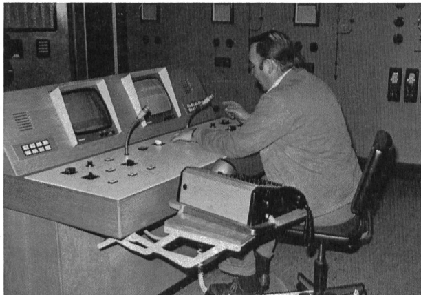
Bild 4. Auf zwei Monitoren im Fernsteuerpult des Kraftwerks können die Bilder der verschiedenen Fernsehkameras wiedergegeben werden. Von hier aus wird die ganze Übersetzaktion kommandiert und ferngesteuert.
