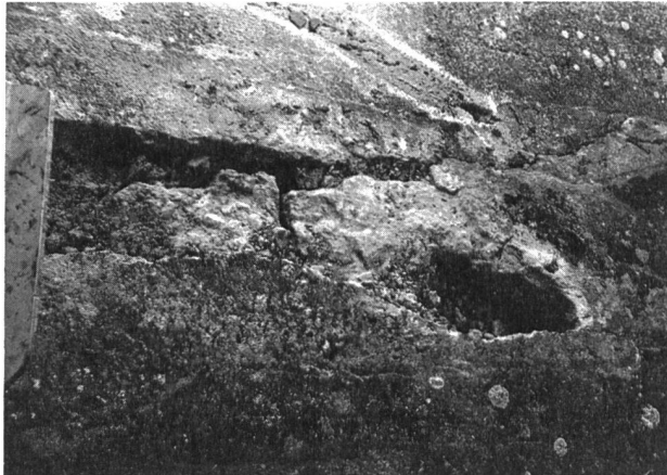
Bild 5. Ein grösserer Schaden an einer Böschungsplatte.
