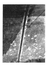
Bild 6. Fertig sanierte Fuge im Bereich des Werkkanals.
