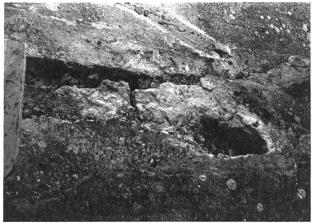
Bild 5. Ein grösserer Schaden an einer Böschungsplatte.
