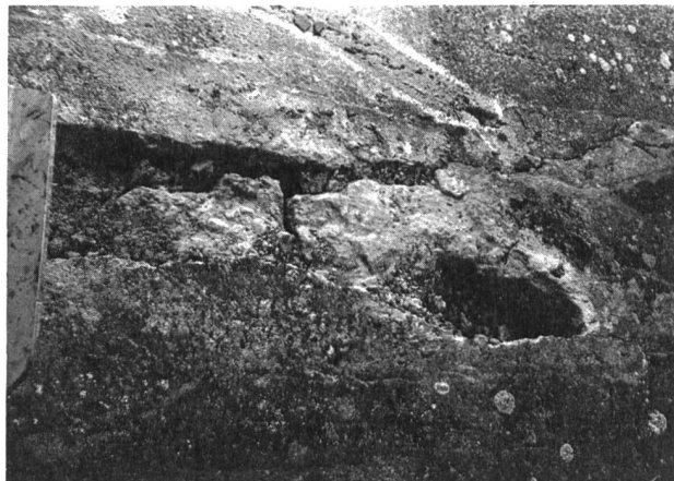
Bild 5. Ein grösserer Schaden an einer Böschungsplatte.
