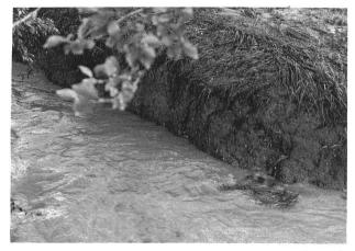
Bild 3. Prallufer eines kleinen Baches nach einem Hochwaser. Die Stelle kann mit verhältnismässig kleinem Aufwand durch den Wuhrmeister repariert werden. Schon nach dem nächsten Hochwasser wird das nicht mehr möglich sein. Der Schaden wird nach kurzer Zeit soweit fortgeschritten sein, dass schon bald systematische Verbauungen notwendig werden.
