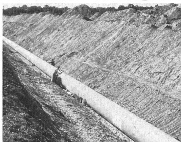
Rohrleitung für aggressives Abwasser Ø 1200 mm
