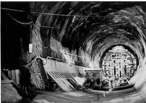
Bild 5. Teilansicht der 130 m langen unteren Kaverne des Wasserschlosses am Ende des 26 km langen Druckstollens; Bauzustand Oktober 1980; rechts hinten im Bild ein Auto als Mass für den Grössenvergleich der 11,5 m hohen Kaverne.
