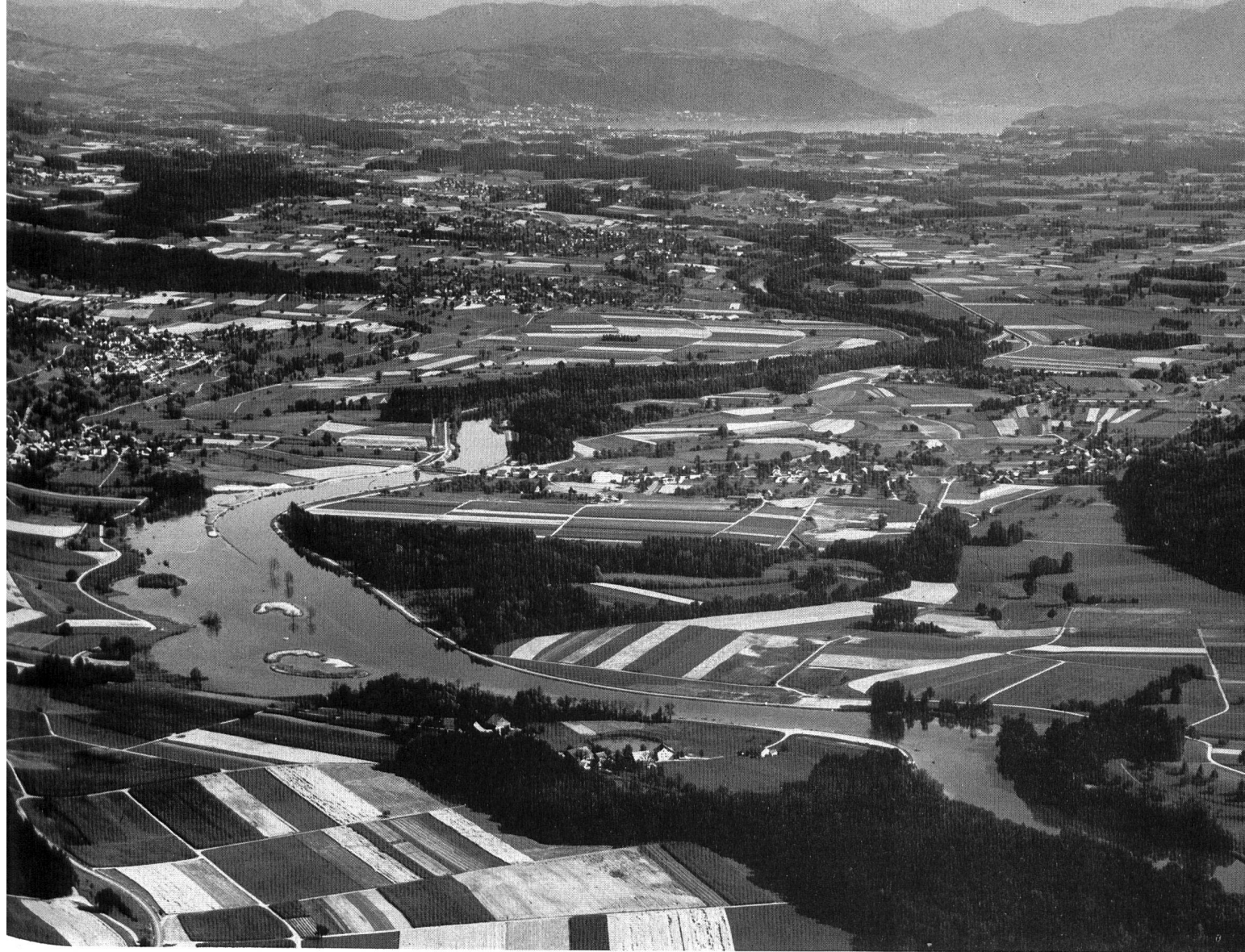
Bild 8. Reusskraftwerk Bremgarten—Zufikon. Naturschutzsee Unterlunkhofen, Blick flussaufwärts. Schaffung einer seichten Bucht durch Weglassen des Uferdamms, Aufschüttung von künstlichen Inseln für die Wasservögel (Foto Comet 1978).
