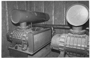
Bild 8. Das Spülluftgebläse ist in einem schallisolierten Gebläseraum aufgestallt
