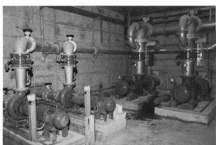
Bild 9. Rechts zwei Spülwasserpumpen, links zwei Schlammwasserpumpen.
