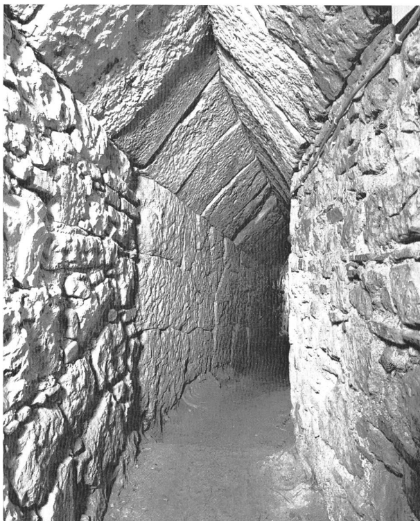
Bild 4. Eupalinostunnel auf Samos. Archaischer Spitzgiebelausbau am Südeingang.
