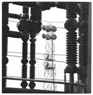
Bild 2. Richtfunk-Antennenanlage in einem Umspannfeld.
