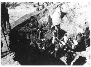
Bild 7. Strassenbau in den nepalesischen Hügeln: Menschen statt Maschinen bewältigen alle Arbeiten. In den sogenannten Tokos (Rückenkörbe) wird der Aushub auf die Seite gebracht. Das Bild stammt von den Arbeiten des Schweizer Proiektes der Jiri-Lamusangu-Strasse.
