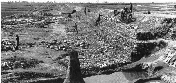
Bild 3. Flussverbau im Terai: Es entsteht ein Hochwasserschutzdamm gegen die Fluten des Ninda-Flusses im Osterai. Die Drahtschotterbauweise ist sehr beliebt, auch wenn sie nicht unproblematisch ist mit stark gerundeten Steinen und oft ungenügenden Fundationen.
