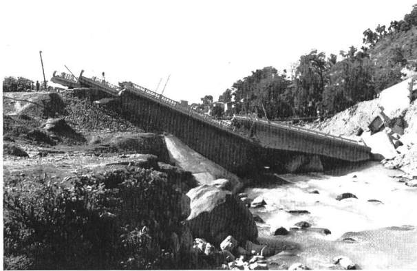
Bild 2. Kurz vor ihrer Fertigstellung im Sommer 1978 wurde diese Stahlbetonbrücke bei Butwal (Zentralnepal) im Terai zerstört. Sie hätte den Tinau Khola (Einzugsgebiet 550 km 2 ) überqueren sollen (East-West-Highway). Das ungenügende Fundament der Brücke widerstand der unerwartet grossen Seitenerosion des Flusses nicht.
