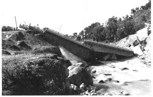
Bild 2. Kurz vor ihrer Fertigstellung im Sommer 1978 wurde diese Stahlbetonbrücke bei Butwal (Zentralnepal) im Terai zerstört. Sie hätte den Tinau Khola (Einzugsgebiet 550 km²) überqueren sollen (East-West-Highway). Das ungenügende Fundament der Brücke widerstand der unerwartet grossen Seitenerrsion des Flüssleins nicht
