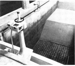
Bild 26. Zweischicht-Schnellfilter im Seewasserwerk Lengg der Stadt Zürich.
