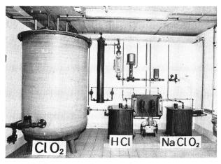
Bild 50. Die CIO<sub>2</sub>-Installation im Seewasserwerk Lengg.
