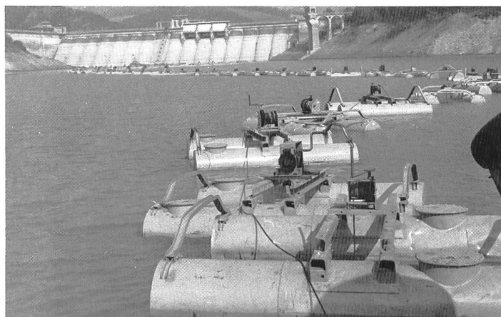
Figure 2, à droite. Lac du Molato (Italie) pendant le nettoyage par la méthode Geolidro. Les boues sont emportées par tuyauterie submergée à un niveau préfixé.
