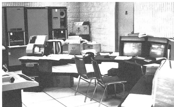
Bild 2. Toronto Highland Creek Sewage Treatment Plant. Blick in den Kommandoraum mit der Computeranlage für die Überwachung der Anlage.
