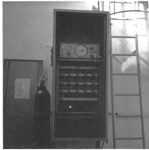
Bild 4. Messzentrale für 16 Peronwasserdruckgeber in der Staumauer Zervreila.
