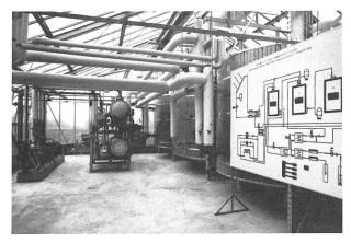
Bild 1. Maschinenraum der Wärmepumpe. Rechts das Leuchtschaltbild mit den Temperaturmessgeräten sowie drei Speichern. In der Mitte die Apparategruppe und links die Verdichter.
