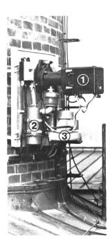
Rauchdichte-Messgerät zur Steuerung einer optimalen Verbrennung und Vermeidung emissionsintensiver Betriebszustände.
