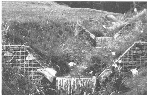
Bild 1: Bachbettverbauung mit Drahtschotterkörben System h+s.
