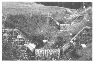
Bild 1: Bachbettverbauung mit Drahtschotterkörben System h+s.
