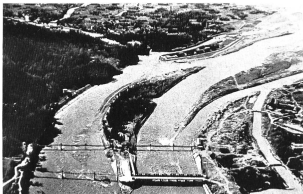
Bild 2. Flugaufnahme der Fassung und der Hochwasserumleitung des Dujiangyan Projektes im Betrieb.
