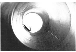
Bild 2. Druckschacht des Umwälzwerkes Grimsel-Oberaar der Kraftwerke Oberhasli AG. Applikation von Epoxidharz-Zinkstaubfarbe «Friazinc R» auf sandgestrahltem Untergrund.
