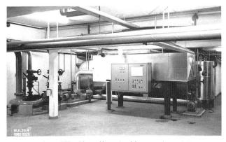
Bild 1. Umgebaute Klärschlamm-Vorpasteurisierungsanlage mit Wärmerückgewinnung, rechts der Wärmetauscher.
