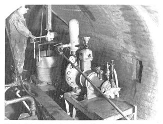
Bild 1. Stolleninjektion mit Injektionspumpe Häny.
