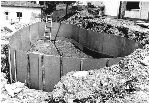
Bild 8: Einhäuptige Schalung aus Pavatex für ein Schwimmbassin aus Spritzbeton (Montagnola, Tessin).
