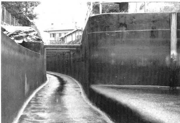
Bild 9: Mit Spritzbeton sanierter Zuleitungskanal samt Einlaufbauwerk aus Natursteinmauerwerk in Ponte Brolla, Tessin.
