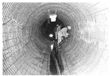
Bild 14, links: Mit Spritzbeton ausgekleideter Freispiegelstollen (Widerlagerbereich geglättet), Nessental (Kraftwerke Oberhasli AG).
