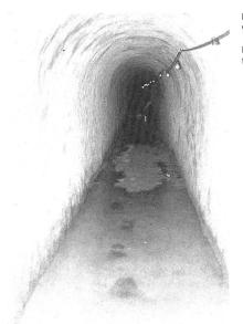
Bild 10, links: Mit Spritzbeton ausgekleideter Abwassersammelkanal in Sonceboz, Kanton Bern.
