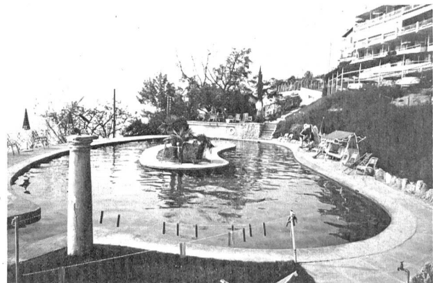
Bild 5: Nierenförmiges Schwimmbassin mit Insel, beide aus Spritzbeton (Alde-sago, Tessin).
