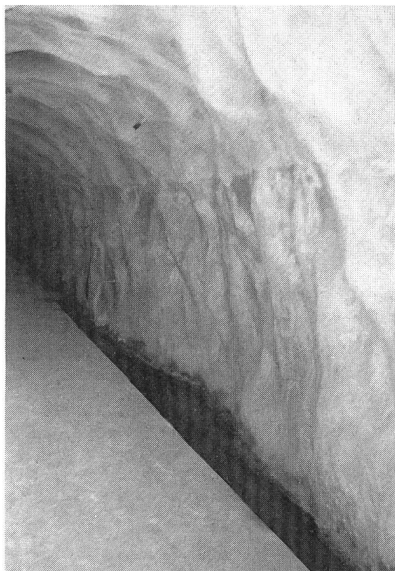
Bild 14, links: Mit Spritzbeton ausgekleideter Freispiegelstollen (Widerlagerbereich geglättet), Nesselstal (Kraftwerke Oberhasli AG).
