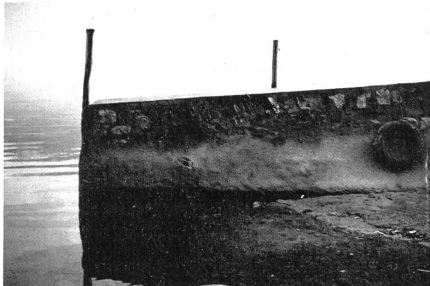
Bild 2: Mit Spritzbeton verfestigte Hafenmauer aus Natursteinmauerwerk in Porto Ronco, Tessin.
