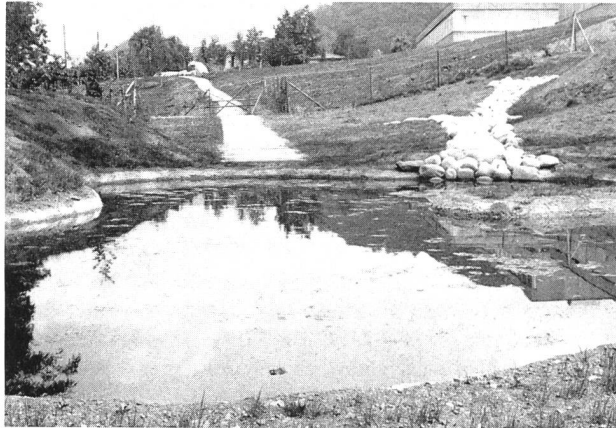
Bild 7: Lehrweiher aus Spritzbeton in Savosa, Tessin.
