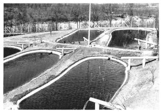
Bild 6: Fischzuchtbecken aus Spritzbeton in Golino, Tessin
