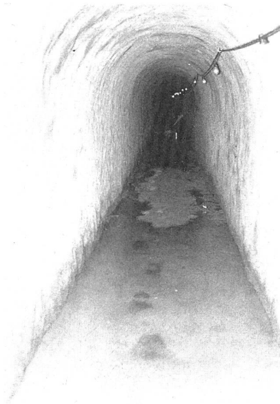
Bild 10, links: Mit Spritzbeton ausgekleideter Abwassersammelkanal in Sonceboz, Kanton Bern.
