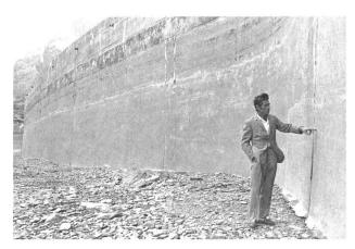
Bild 4: Mit Spritzbeton reparierte Wasserseite der Betonstaumauer Nord des Lago Bianco der KW Brusio AG.
