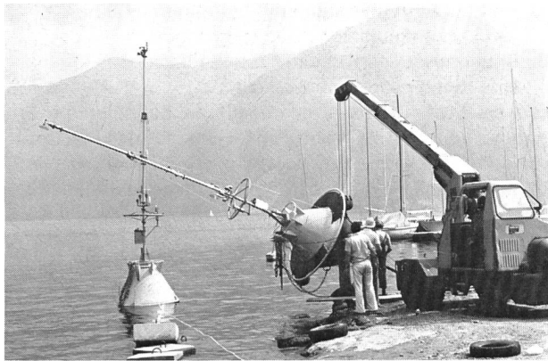
Bild 9. Einwässerung meteorologischer Bojen. Bojenlänge ü. a.: 12 m, Gewicht: 1,2 t.
