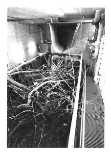
Bild 1, links. Das am Maschinenhausrechen mit der Rechenreinigungsmaschine dem Wasser entnommene Geschwemmselmaterial (Äste, Laub, Moos, Seegras, Autopneus usw.) wird über eine Einlaufrinne in den im Geschwemmselraum bereitstehenden Grosscontainer mit 24 m³ Fassungsvermögen gespült.
