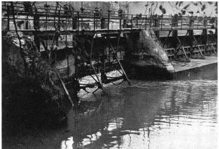
Bild 5. Ansicht der bestehenden, von Erosionsschäden gekennzeichneten Oberwasserkanalmauer. Links bereits vorbetonierter Mauerteil.
