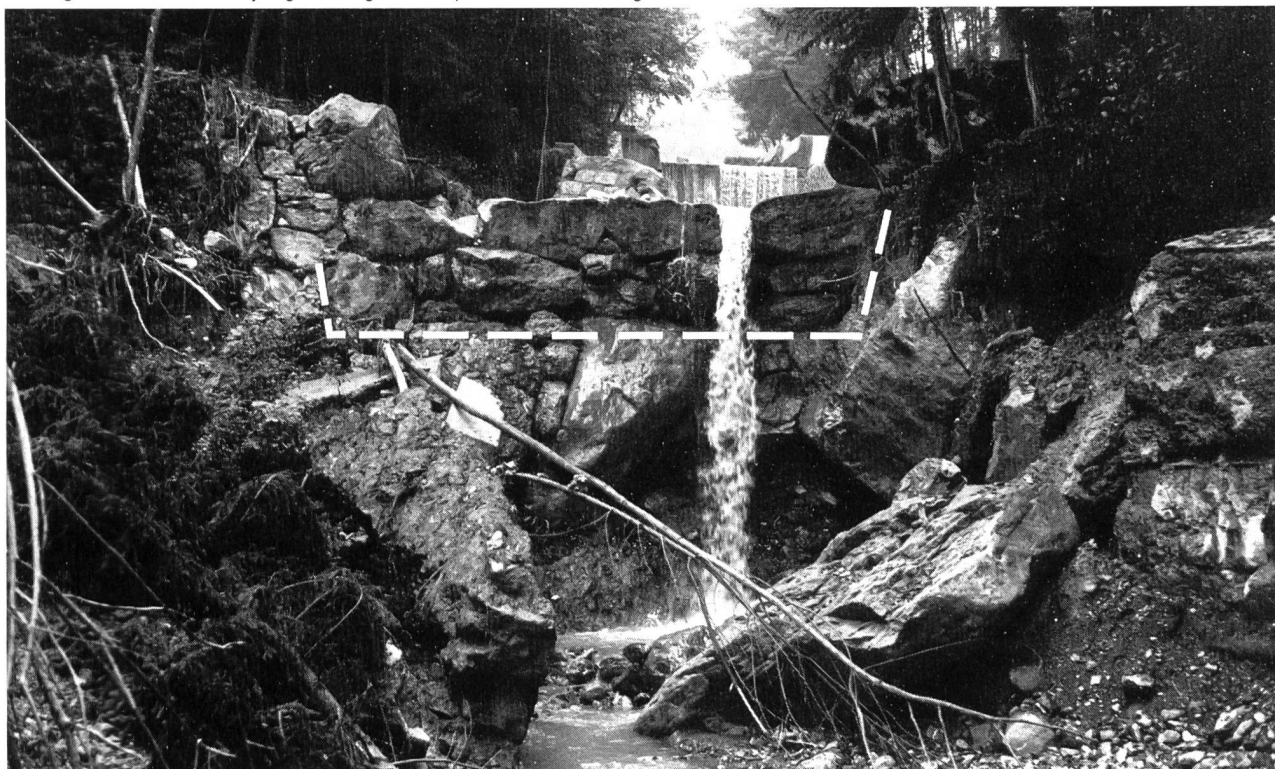
Bild 7. Steinibach bei Hergiswil NW: Blocksperre Nr. 61 bei Kote 645 m ü. M., welche dank günstigem Standort erhalten blieb, obwohl die unterhalb befindlichen Sperren zerstört und abtransportiert wurden; jetzige Fallhöhe rund 6 m, ursprünglich rund 2 m. Die frühere Sperrenansicht im intakten Zustand ist gestrichelt eingetragen. Insbesondere das Ufer rechts im Bild ist vollständig abgerutscht. Einige nicht abtransportierte Blöcke (Trümmer des Längsverbaues) liegen im rund 4 m eingetieften Bachbett. Das jetzige Sohlengefälle entspricht etwa dem Grenzgefälle.
