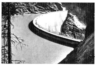
Figure 2. Le barrage de Gebidem construit entre 1964 et 1967,  $8,5\,$  mio  $m^3\,$  de volume utile. Hauteur 122 m. Volume du béton 228  $000\,$  m $^3.$
