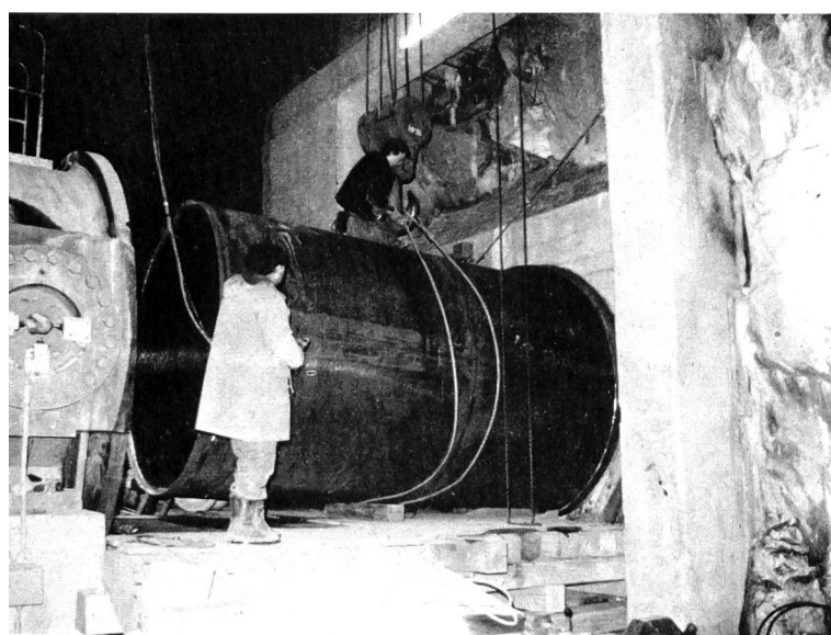
Figure 5. Entrée d'une virole dans la galerie d'amenée par la chambre de la vanne de Gebidem.
