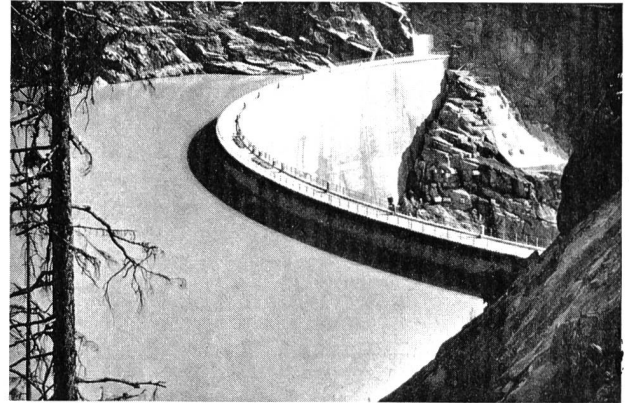
Figure 2. Le barrage de Gebidem construit entre 1964 et 1967. 8,5 mio m 3 de volume utile. Hauteur 122 m. Volume du béton 228 000 m 3 .
