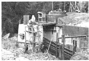
Bild 6. Blick vom Oberwasser gegen das rechte Widerlager mit Hochwasser-Entlastungsöffnung und rechtem Wehrpfeiler, Bauzustand Dezember 1979.
