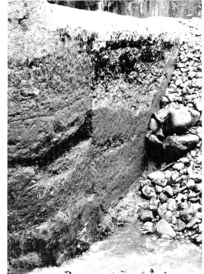
Bild 2, links. Unterwasserseitige Ansicht der festen Wehrmauer der Wasserfassung Trepsenbach mit Frostschäden, Durchsickerungen und zerstörter Sohlenpflasterung durch Kolkwirkung. Oberhalb der Wehrkrone ist die vollständige Auflandung des Stauraumes zu erkennen.
