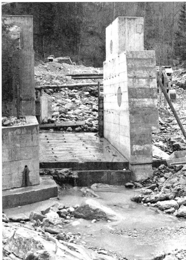
Bild 7. Ansicht von Unterwasser der Hochwasser-Entlastungsöffnung und der Wehröffnung, Bauzustand März 1980.
