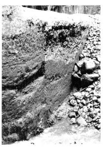
Bild 2, links. Unterwasserseitige Ansicht der festen Wehrmauer der Wasserfassung Trepsenbach mit Frostschäden, Durchsickerungen und zerstörter Sohlenpflästerung durch Kolkwirkung. Oberhalb der Wehrkrone ist die vollständige Auflandung des Stauraumes zu erkennen.
