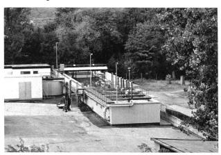
Bild 2. Anlage mit Regelung über Rücklaufschlamm und Klarwasser- Rückführung sowie Steuerung über den spezifischen Sauerstoffbedarf.
